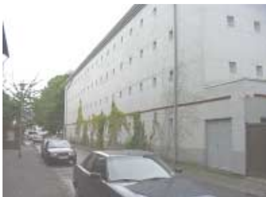
Abb. 1: Bunker der Stadt Münster, in dem die Versuche durchgeführt wurden. Das Gebäude wurde 1943 errichtet und verfügt über 3m dicke Stahlbetonwände.
