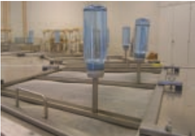
Bild 23: Rundhohlleitungsstücke als Dämpfungskamine über den Käfigen zur Durchführung der Trinkwasserstutzen
