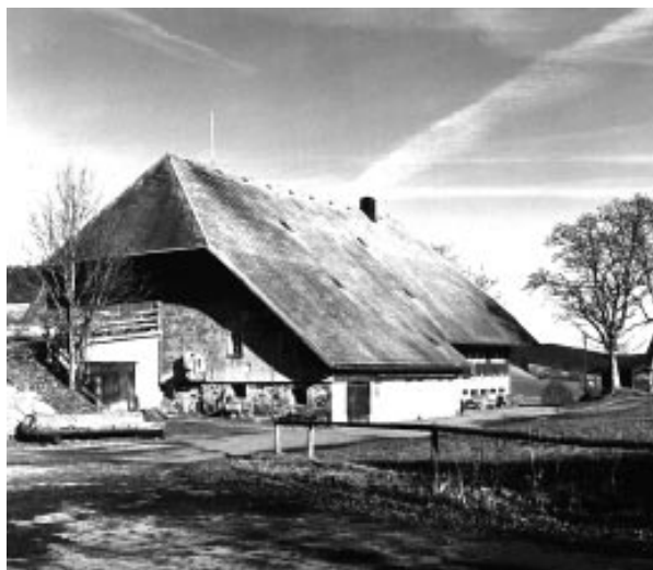
Die Nachfrage nach Funkverbindungen hat sich in den letzten Jahren erhöht. Hier eine D2-Basisstation im Schwarzwald (Foto: Mannesmann Mobilfunk)
