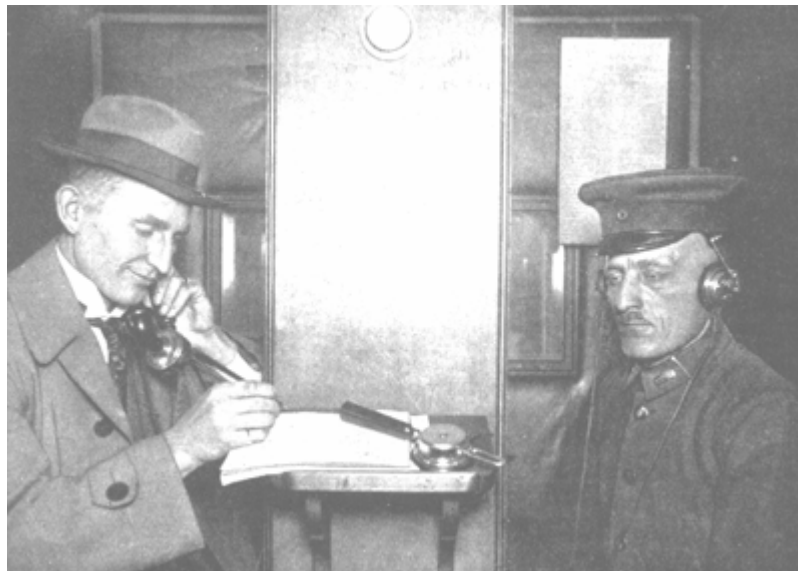
Bild 1: Telefoneinrichtung im fahrenden Zug
